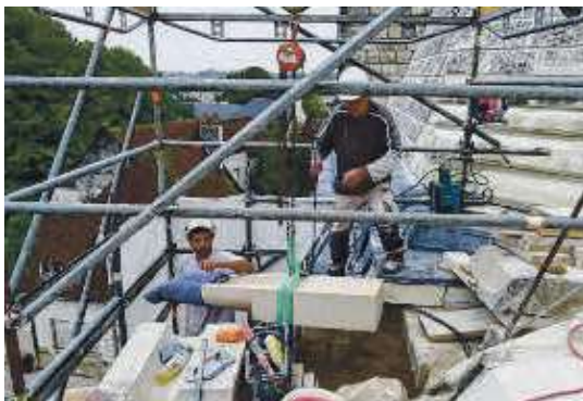
Installation d'une des deux gargouilles à 14 m de hauteur.
